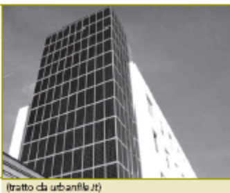
FIGURA 2 Esempio di fotovoltaico a moduli policristallini, integrato nella facciata.
