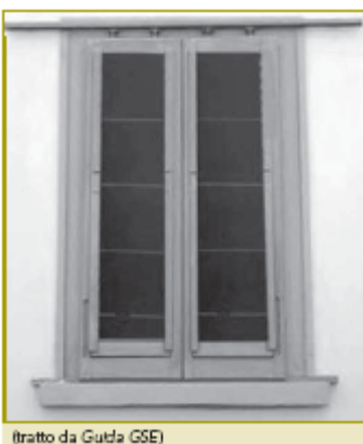
FIGURA 3 Esempio di pannelli fotovoltaici integrati nelle persiane.
